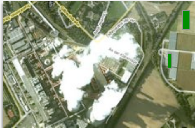
1.8 GW Kohlekraftwerk RWE 600 m 2 / 1600 m 2 Bioreaktor
